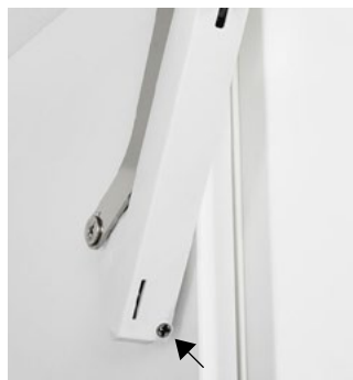
Налаштування сили пружини
